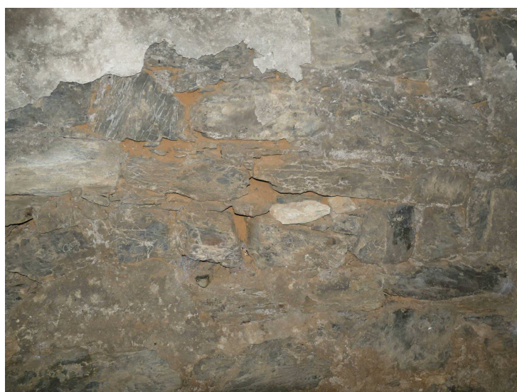
Foto č. 6 – Opěra O 04 – střední část, vypadané spárování, rozvolněné zdivo, odpadlá povrchová úprava
