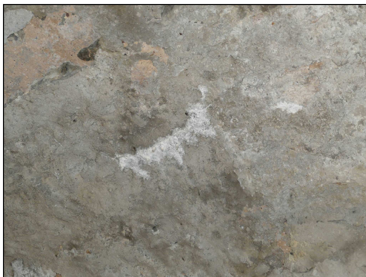
Foto č. 2 – Konstrukce K 02 – podhled, průsaky s výluhy pojiva
