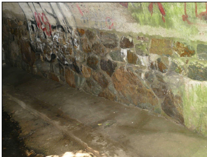
Foto č. 4 – Opěra O 01 – průsaky s výluhy pojiva
